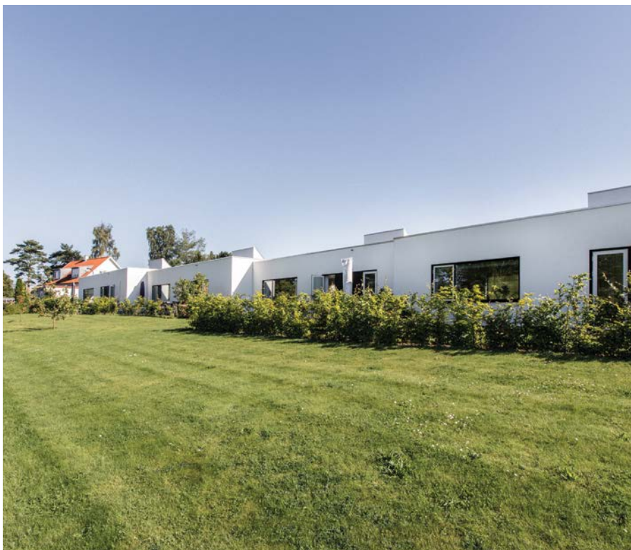
Gårdhavehuse ved Nærumgårdsvej. Gårdhavehuse er tegnet af Lind og Risør
